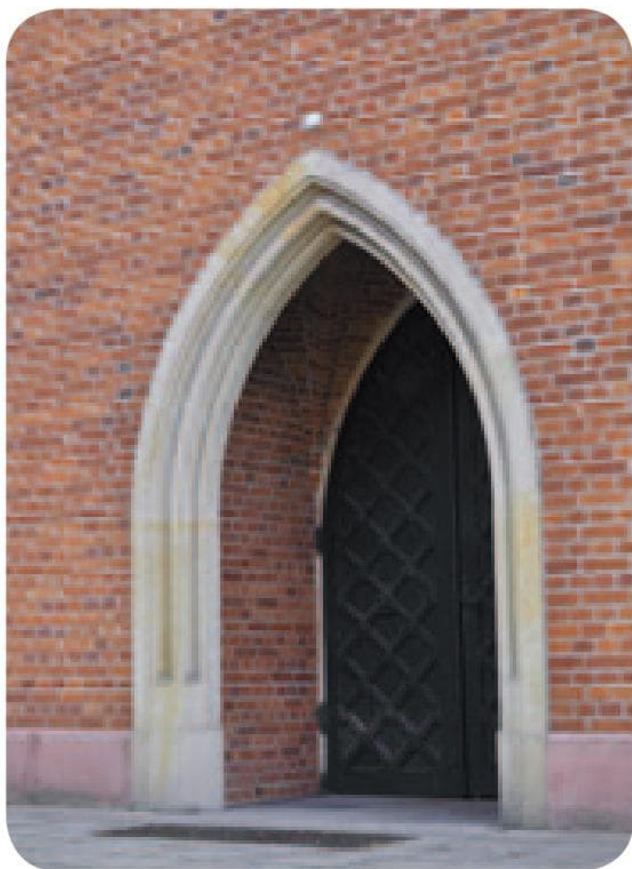
>>> Portal główny z datą remontu kościoła
