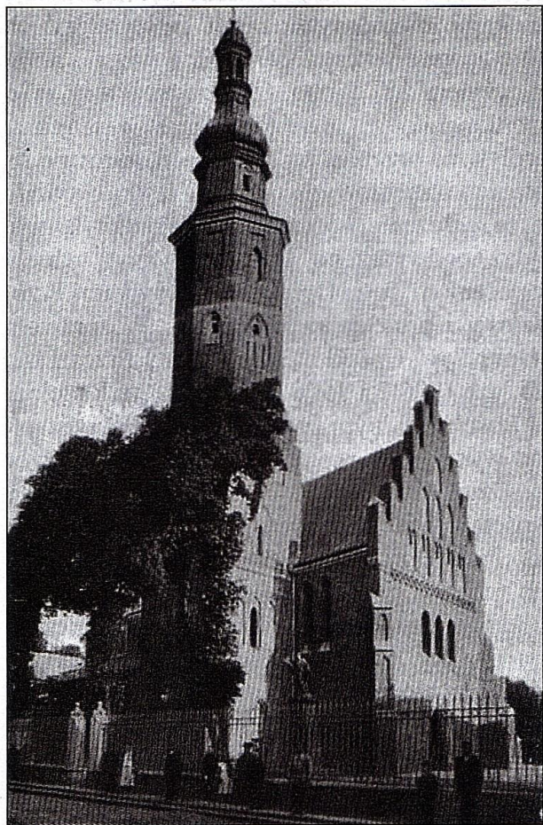
Widok na nową fasadę
