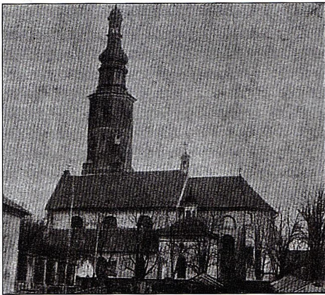
Fara przed przebudową
